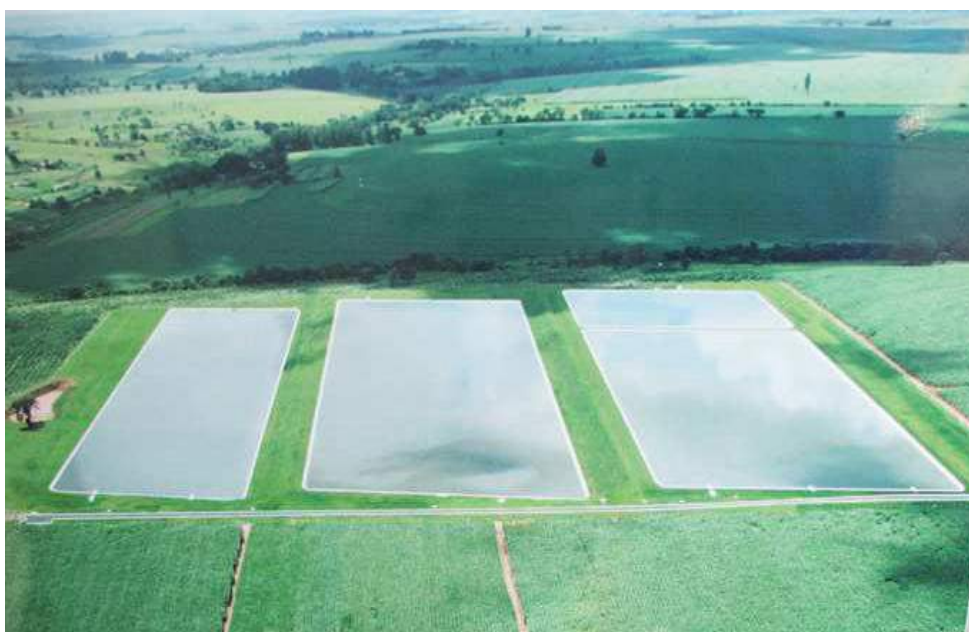
Foto17 – Estação de Tratamento de Esgoto – ETE Fortuninha.
