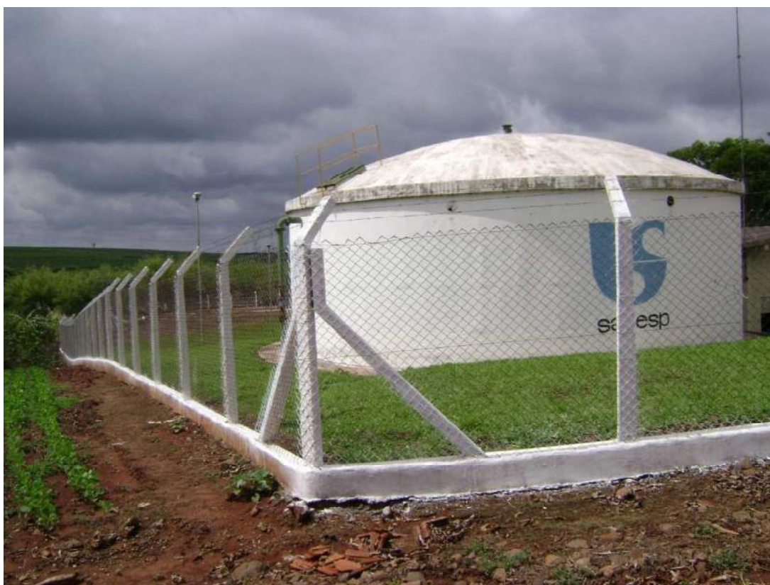
Foto 15 – Reservatório 500m3 Matão
