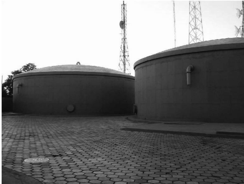
Foto 13 - Reservatório 2000m3 Vila Fiúza
