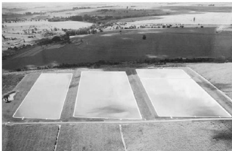
Foto17 - Estação de Tratamento de Esgoto - ETE Fortuninha.
