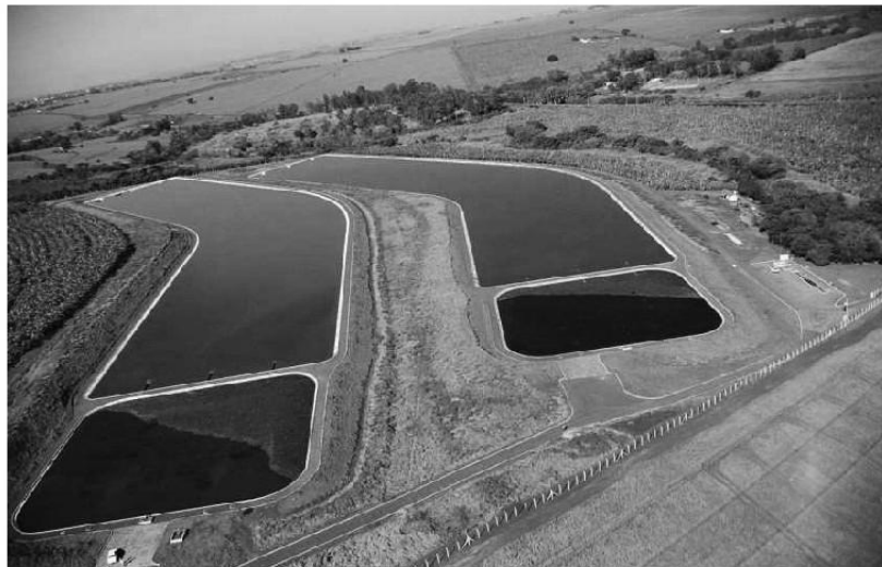
Foto 16 - Estação Tratamento de Esgoto. ETE Jacu.
