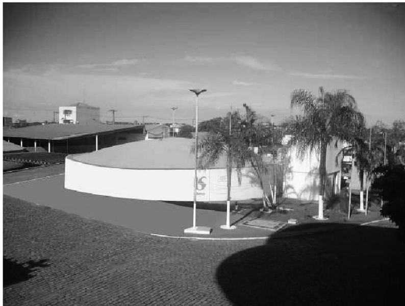
Foto 11 - Reservatório Pulmão 2000m3. Estação Tratamento de Água. ETA Boa Vista.
