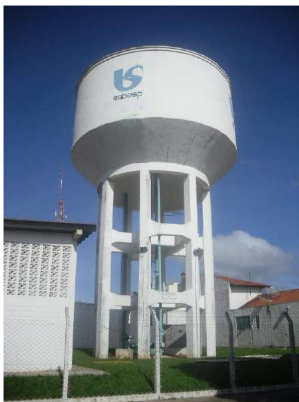
Foto 14 – Reservatório 450m3 Vila Xavier
