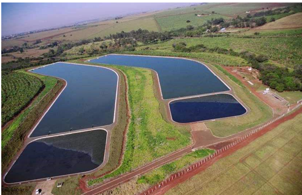
Foto 16 – Estação Tratamento de Esgoto. ETE Jacu.
