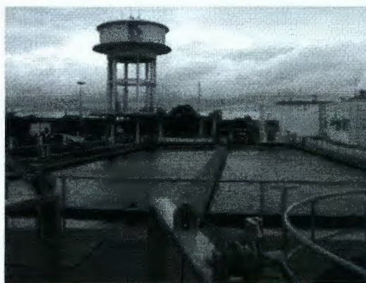
Figura 04 - Estação de Tratamento de Água (ETA).
