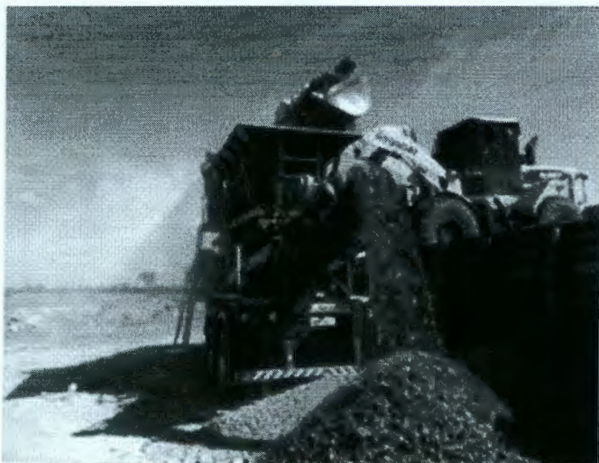
Figura 10 - Resíduo da construção civil beneficiado.
