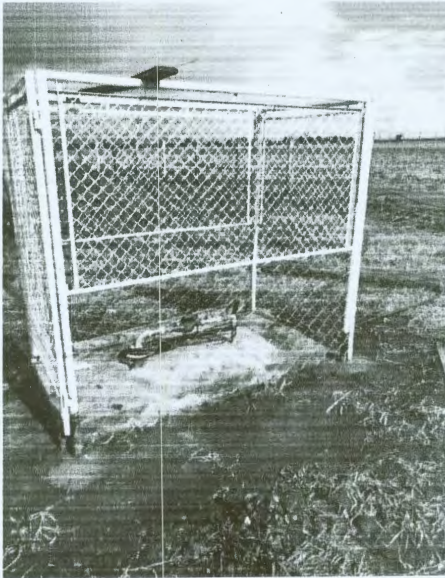
Foto com vista geral da área do poço a ser outorgado, com cerca de isolamento do perímetro imediato com entrada de acesso e laje de proteção sanitária.
