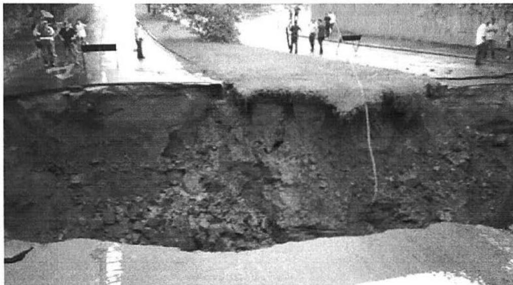
Foto 4 – Detalhamento da ruptura da estrutura de drenagem da travessia
