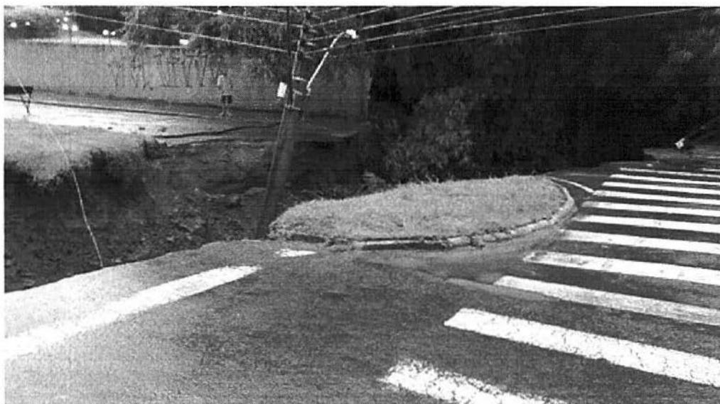
Foto 3 – Logo após o escoamento das águas, com a ruptura da travessia
