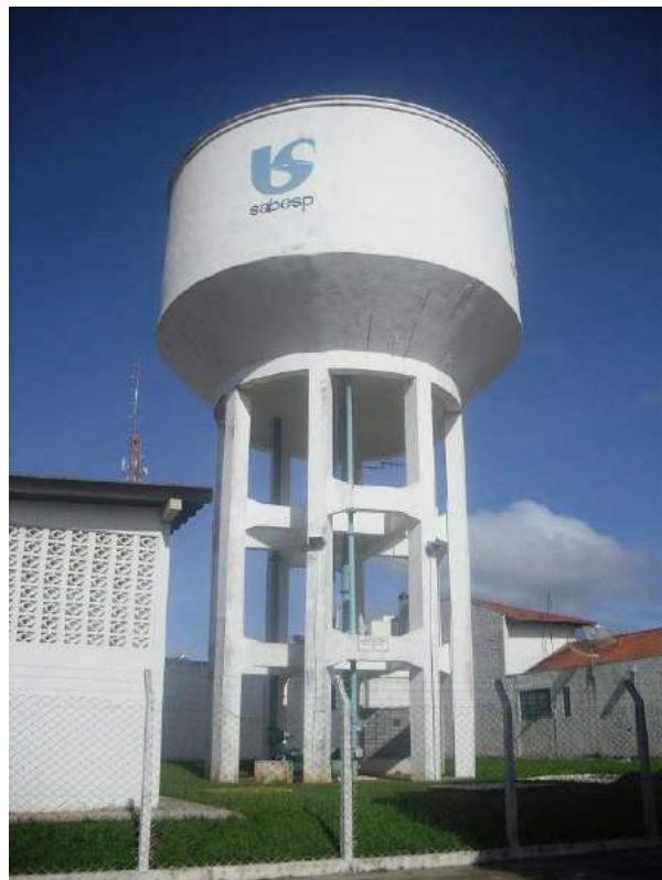
Foto 14 – Reservatório 450m3 Vila Xavier
