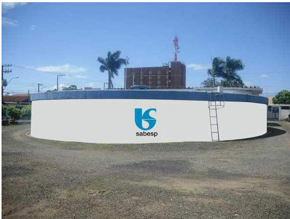
Foto 12 - Reservatório 2000m³ Estação de Tratamento de Água – ETA Boa Vista
