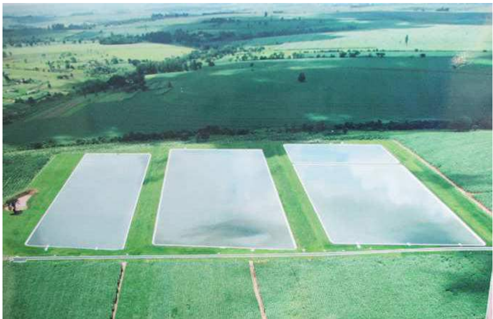
Foto17 – Estação de Tratamento de Esgoto – ETE Fortuninha.
