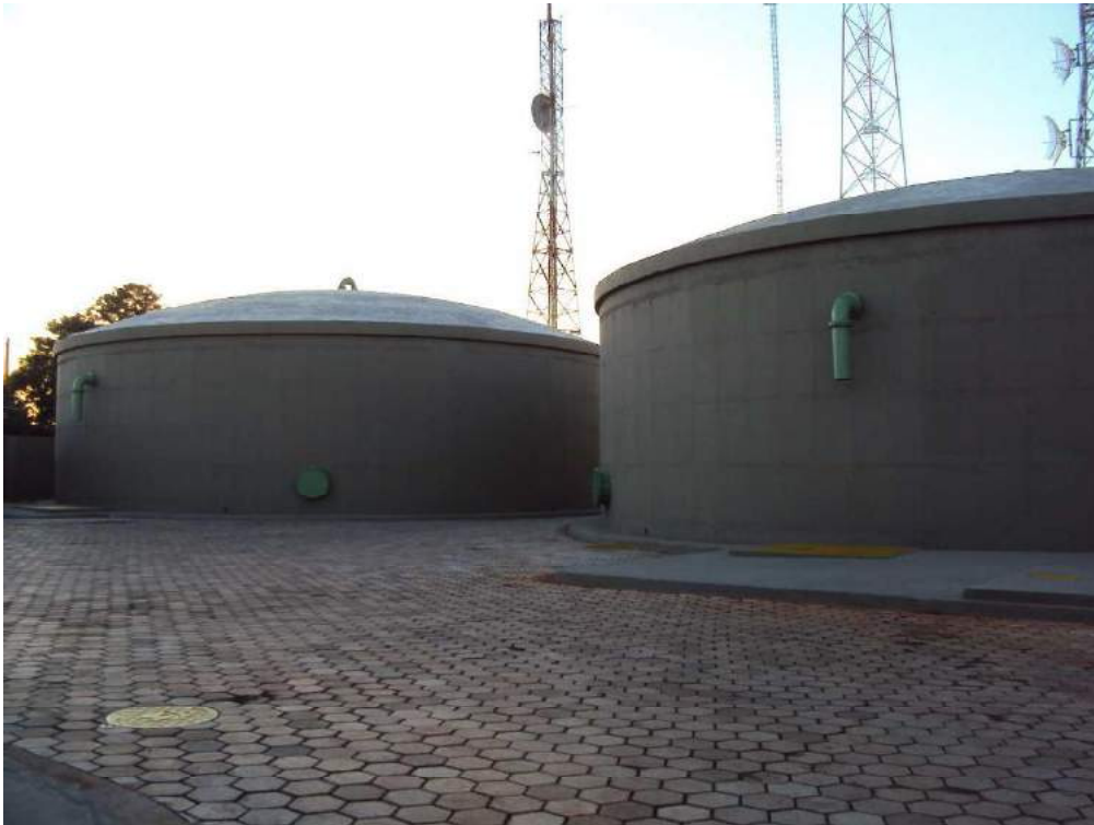
Foto 13 – Reservatório 2000m3 Vila Fiuza
