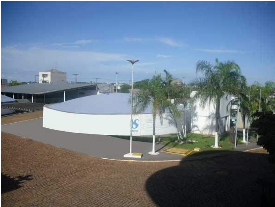
Foto 11 – Reservatório Pulmão 2000m³. Estação Tratamento de Água. ETA Boa Vista.
