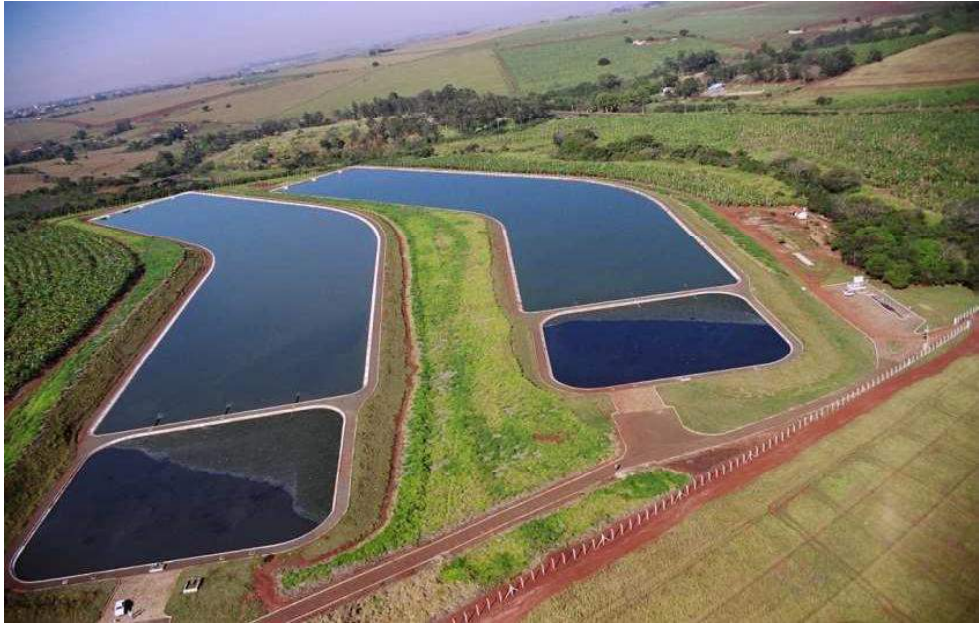
Foto 16 – Estação Tratamento de Esgoto. ETE Jacu.
