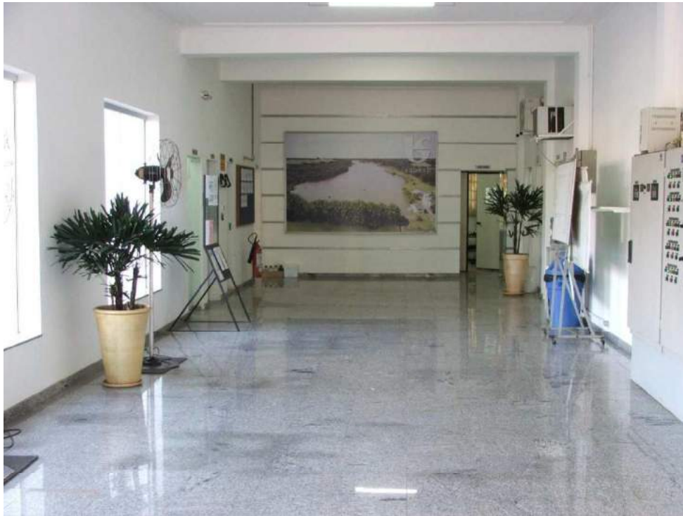
Foto 09 – Estação de Tratamento de Água – ETA Boa Vista. Vista Interna.
