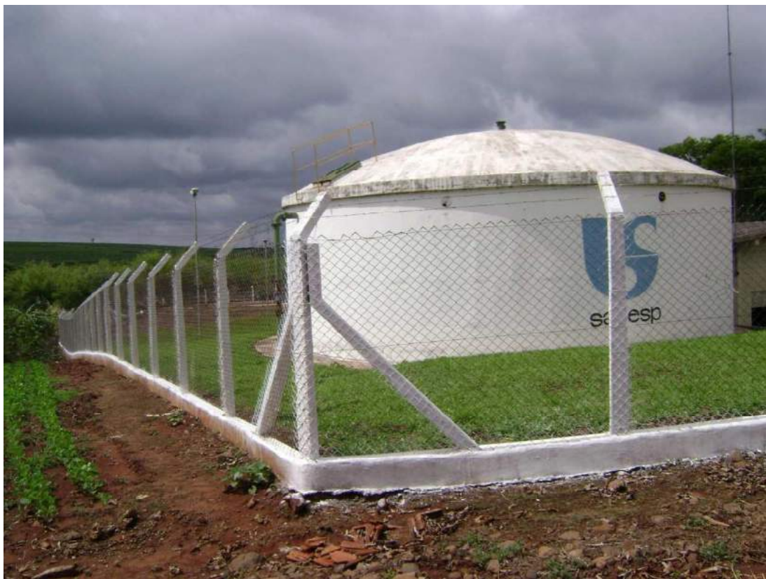
Foto 15 – Reservatório 500m3 Matão
