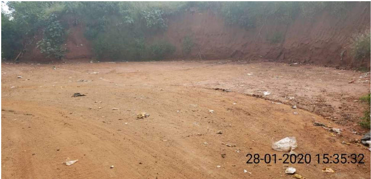
Foto 3: área de manobra da carreta para entrada na baía de carregamento.
