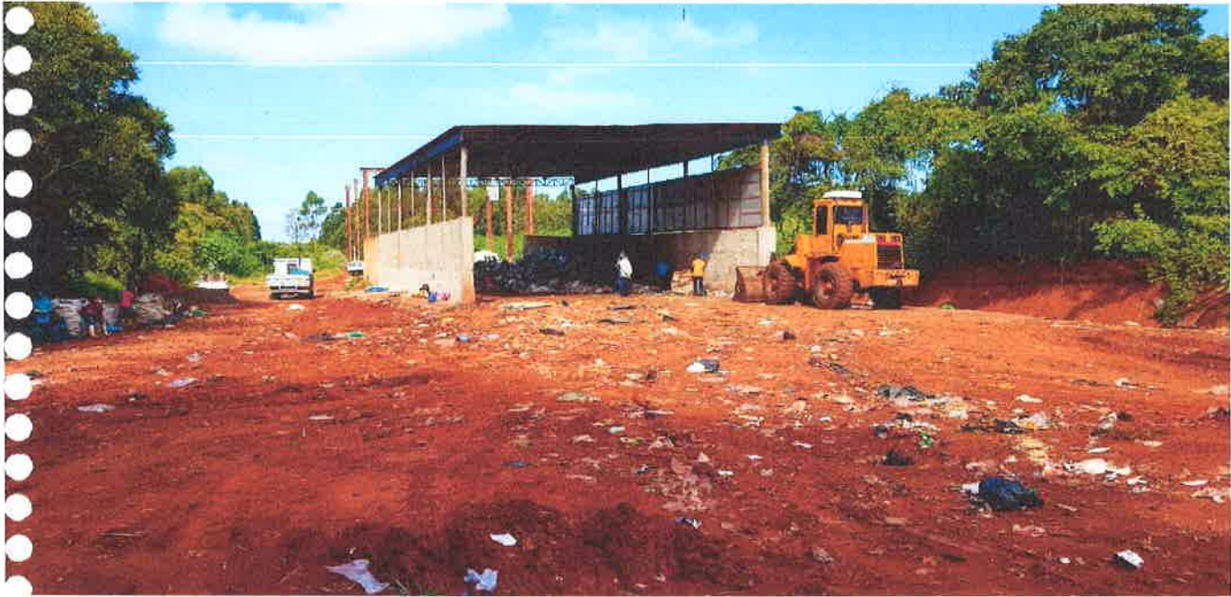
Figura 2 – Vista geral da área de transbordo.
