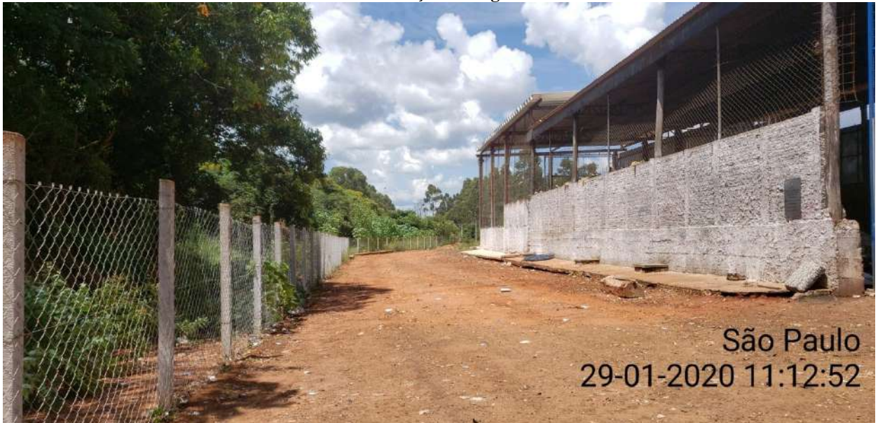
Foto 3: lateral esquerda do barracão mostrando as caixas coletoras chorume e alambrado de divisa.
