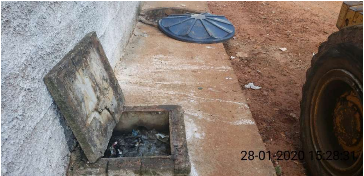
Foto 10: caixa intermediária coletora de chorume.
