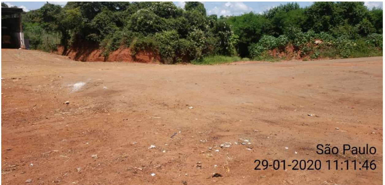
Foto 14: vista frontal direita do pátio de manobra
