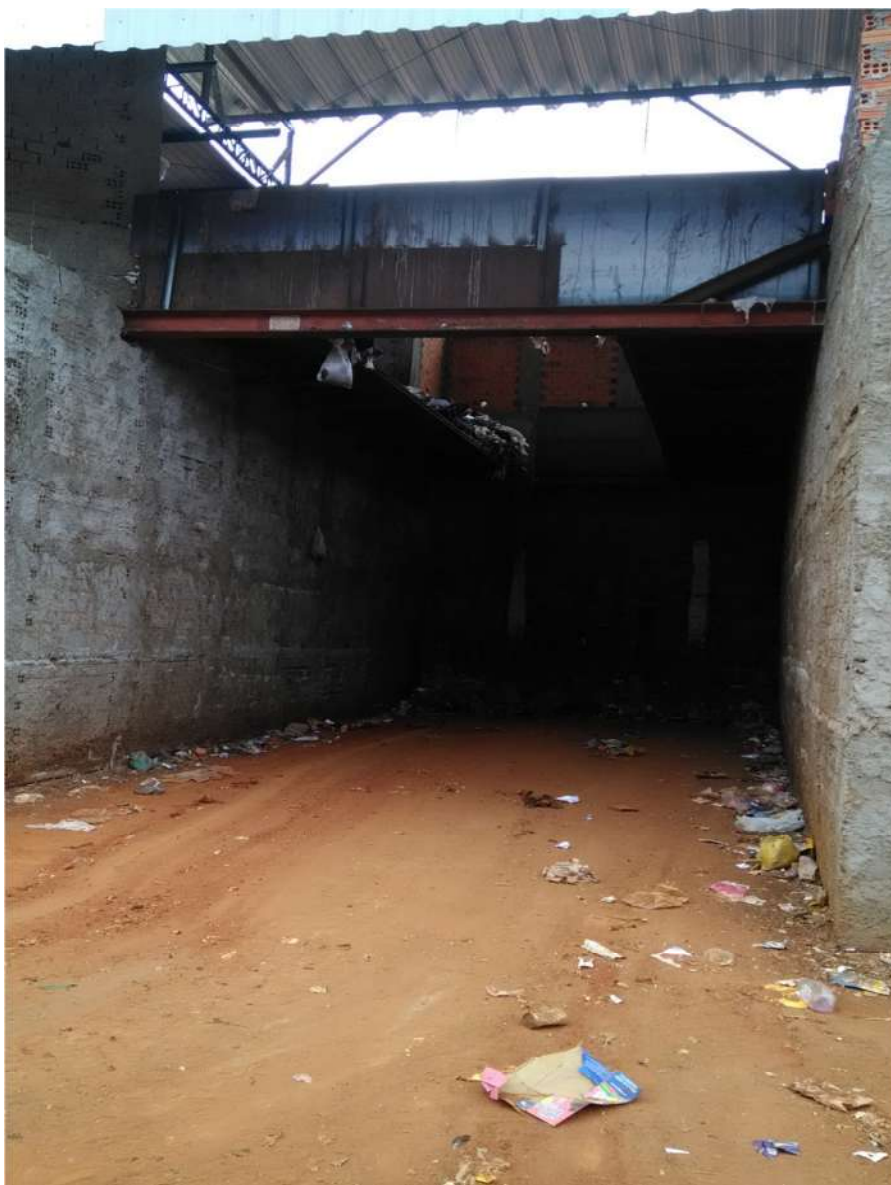
Foto 05: Local de entrada de caminhões para carregamento dos resíduos sólidos
