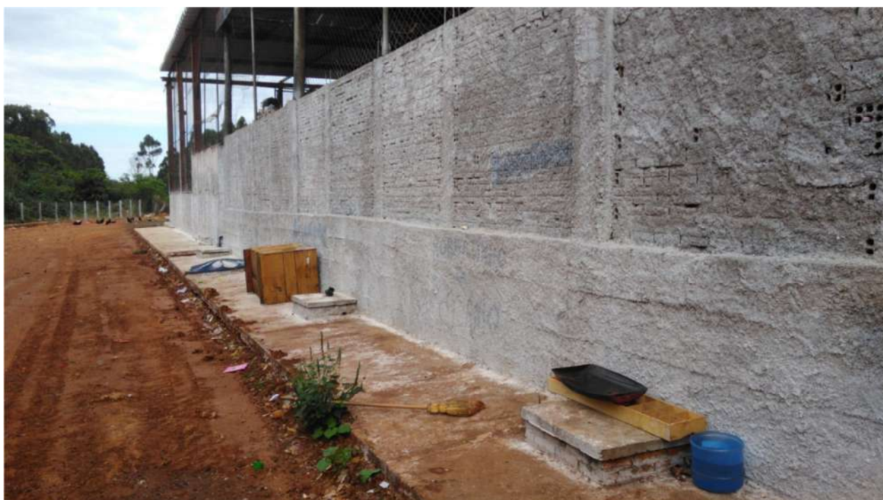
Foto 03: Lateral esquerda da construção do transbordo
