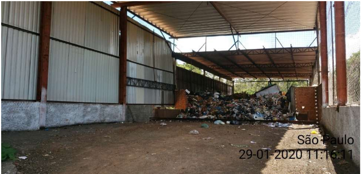
Foto 17: vista interna do depósito de RSU e baia de carregamento.
