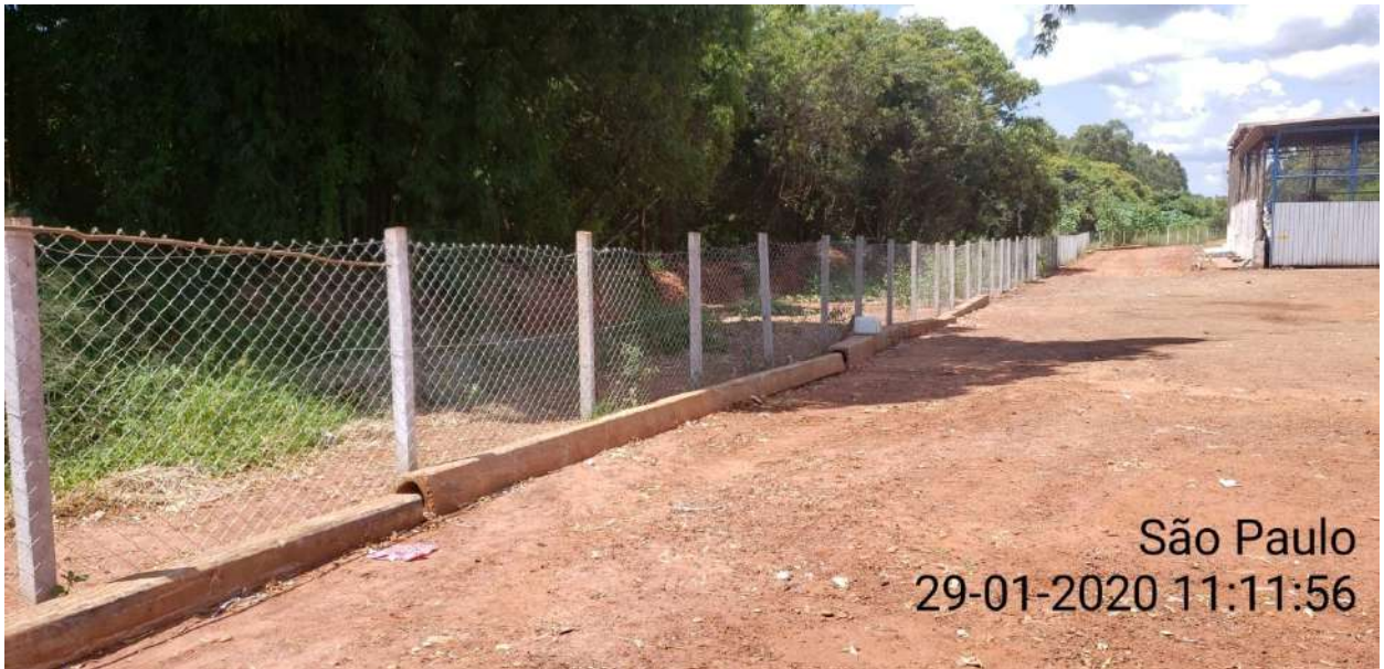
Foto 15: vista frontal esquerda pátio de manobra.
