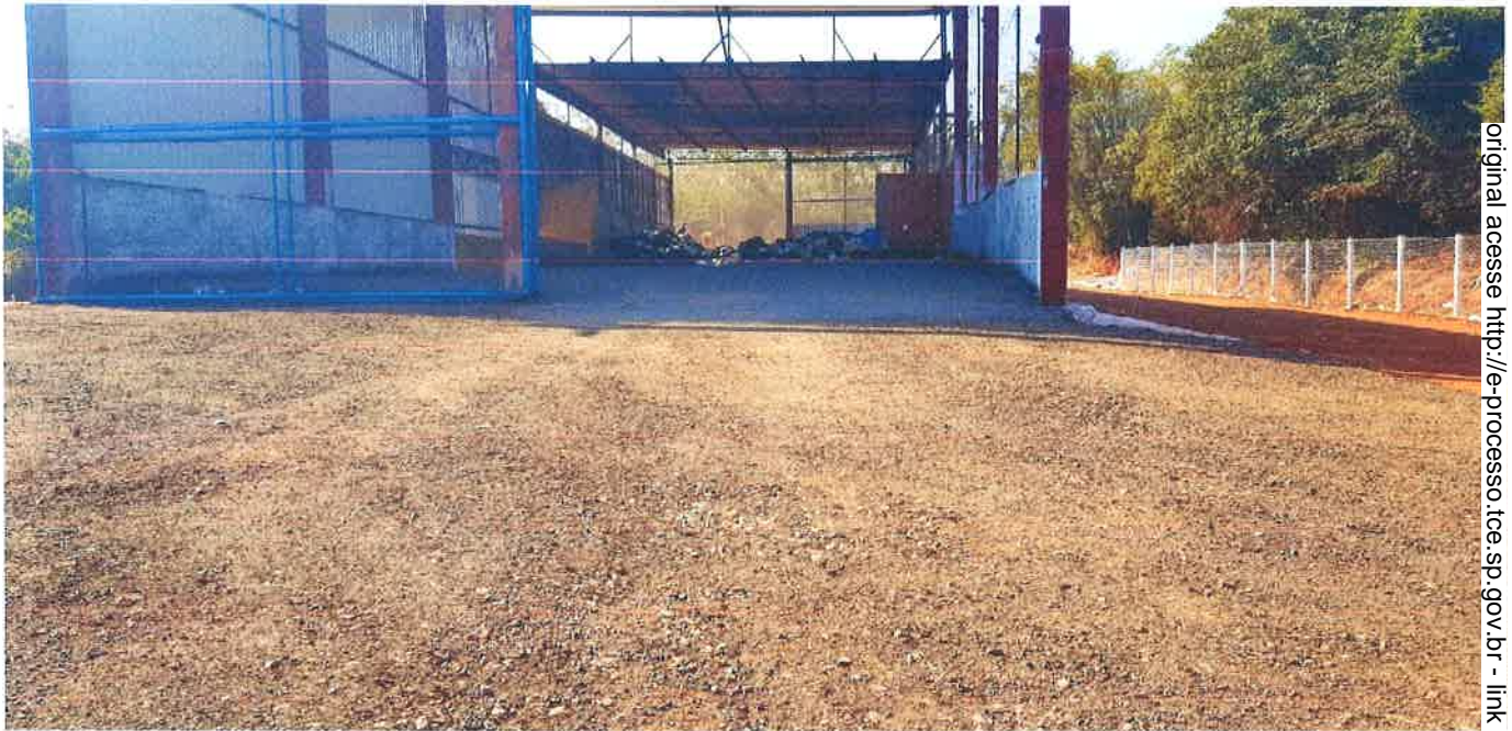
Figura 4 – Obras de melhoria que foram realizadas na área de transferência
