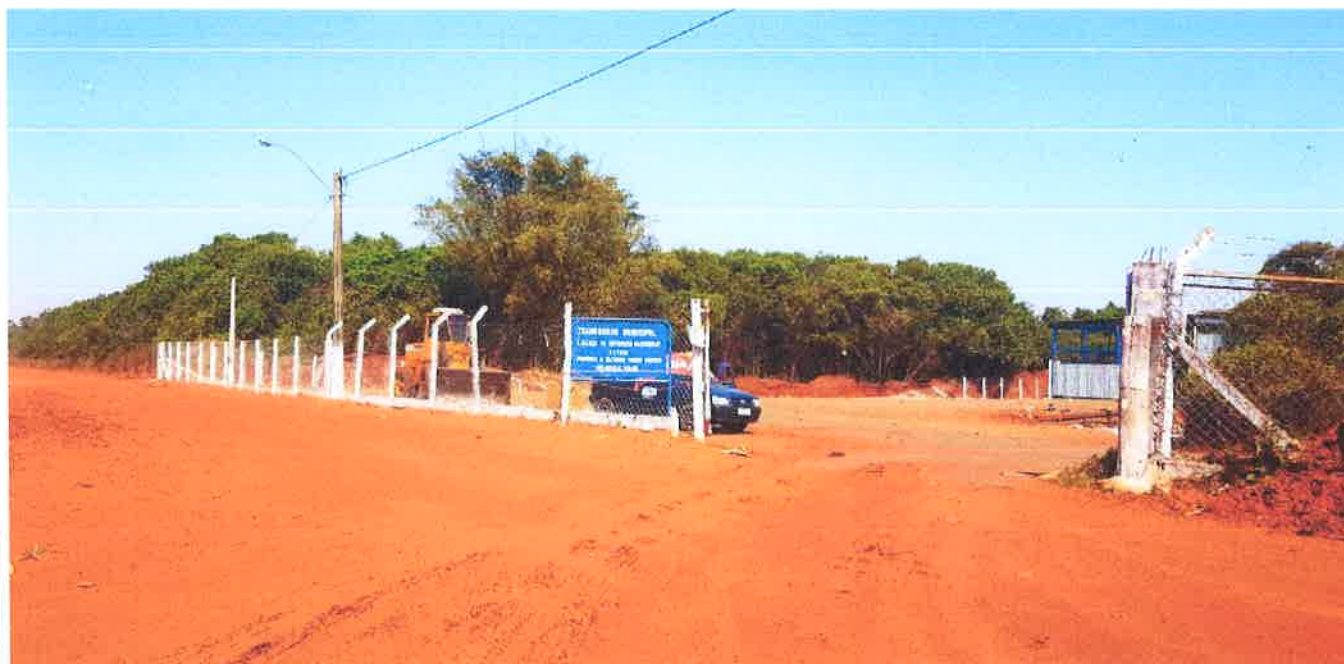
Figura 1 – Portão de acesso ao transbordo
