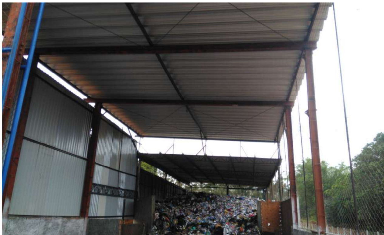
Foto 06: Alambrados, telhas e trilhos utilizados para cobertura e fechamento do transbordo
