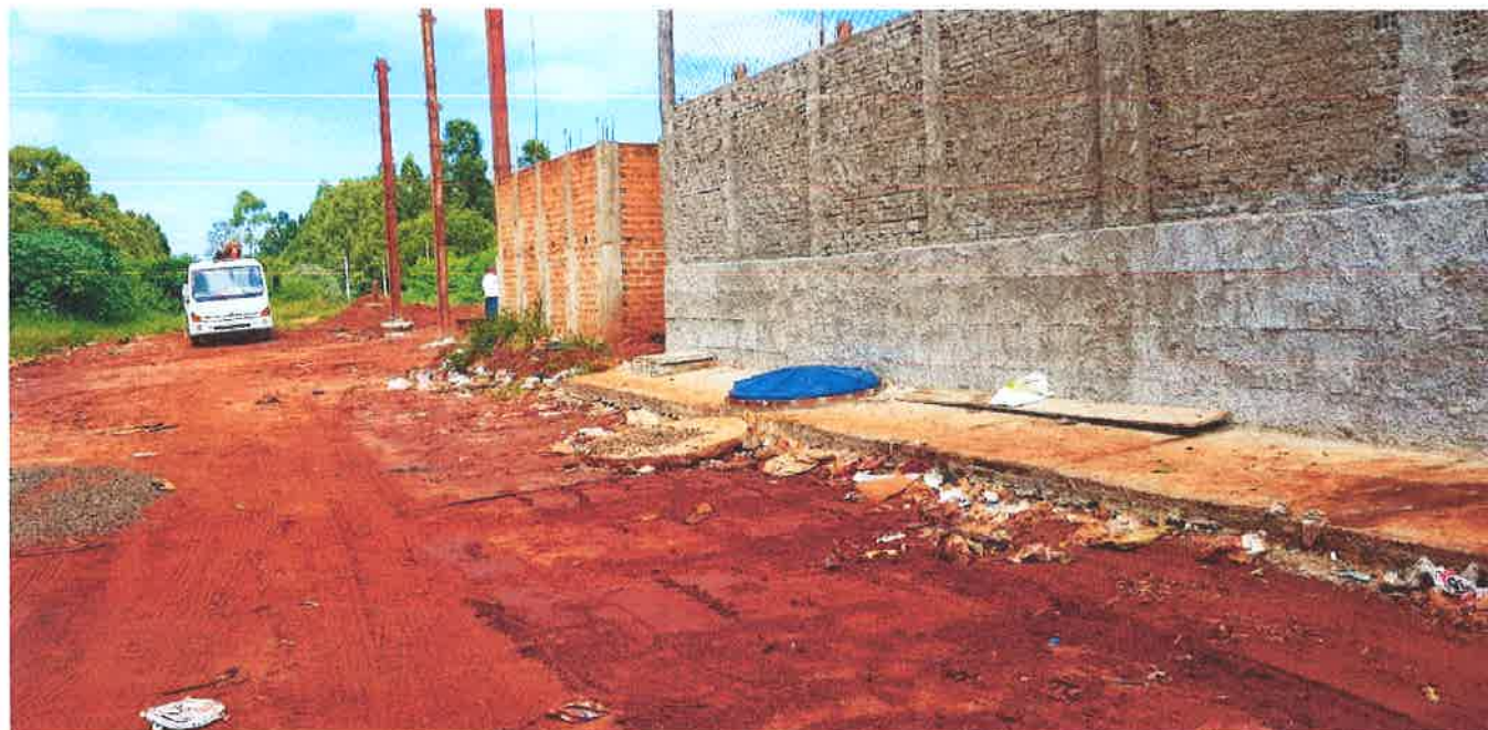
Figura 5 – Caixa de coleta de chorume da área coberta de recebimento dos resíduos sólidos urbanos.
