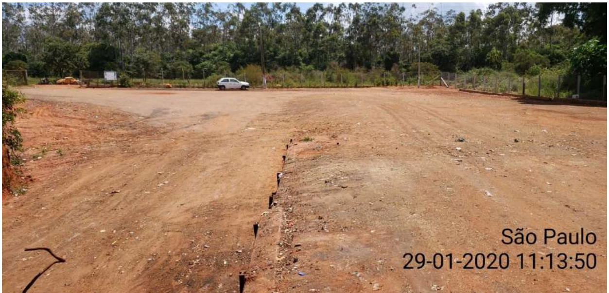
Foto 6: vista interna do pátio de manobra.
