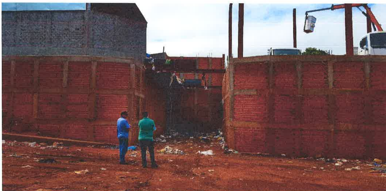
Figura 4 – Obras de melhoria na área de transferência
