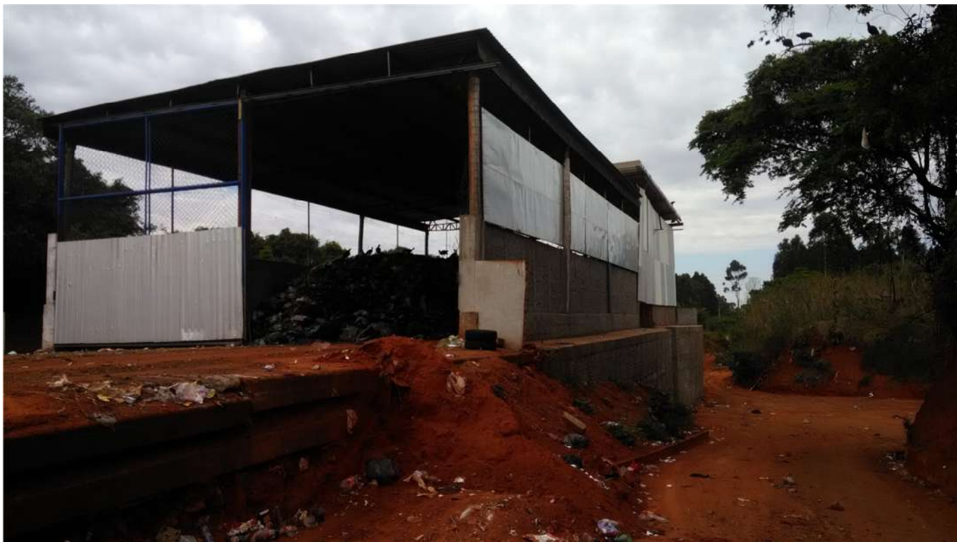
Foto 01: Portão de entrada e lateral direita do transbordo
