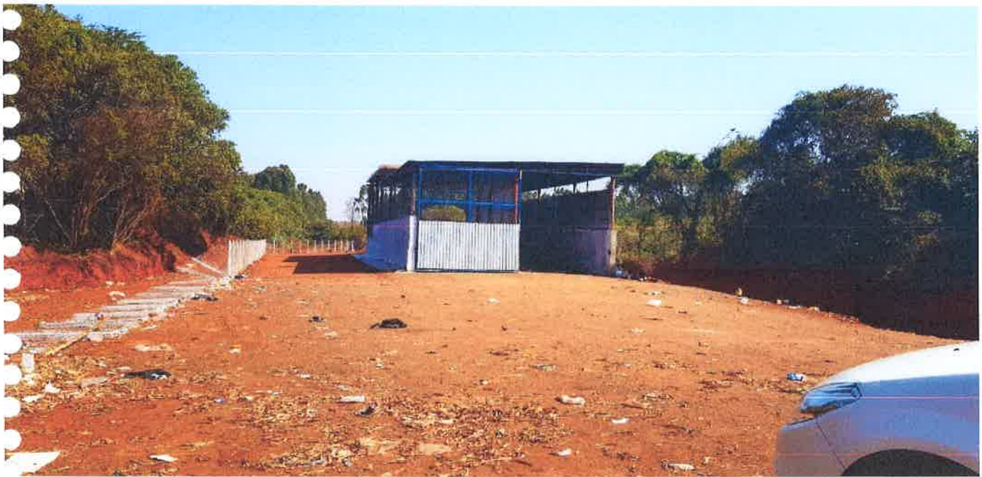
Figura 2 – Vista geral da área de transbordo.
