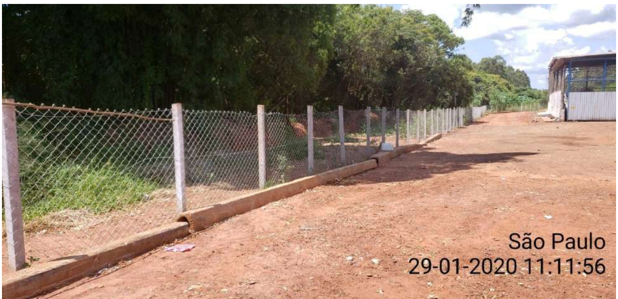
Foto 5: alambrado de divisa entre o transbordo e a área de preservação.
