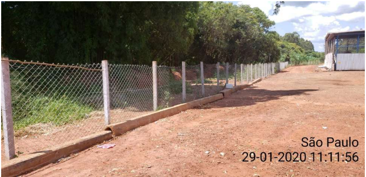
Foto 5: vista frontal esquerda pátio de manobra.
