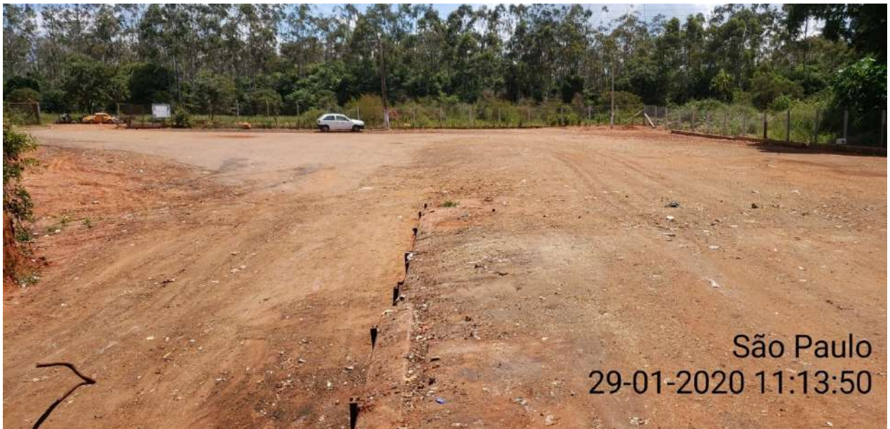
Foto 16: vista interna do pátio de manobra.
