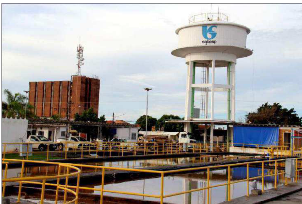
Foto 10 – Estação Tratamento, Decantação e Reservação 1250m2. ETA Boa Vista.
