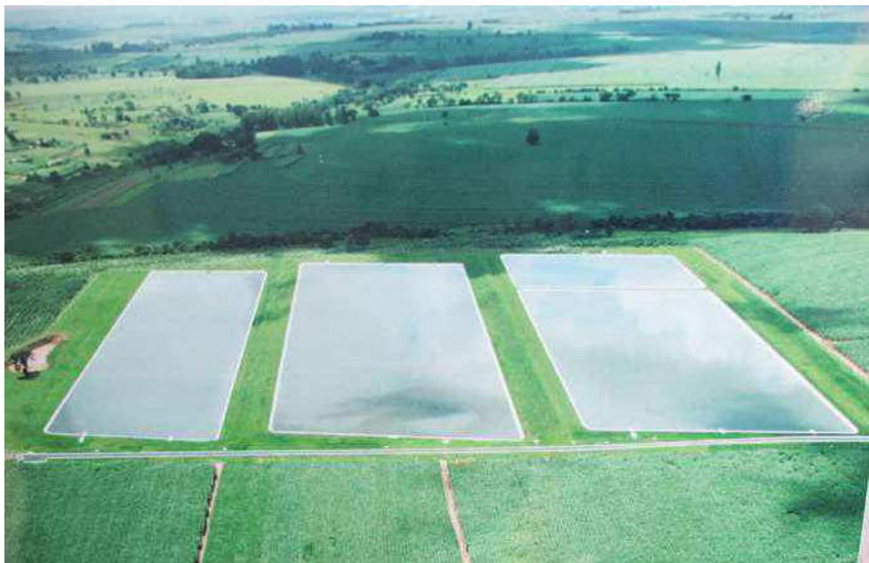
Foto17 – Estação de Tratamento de Esgoto – ETE Fortuninha.
