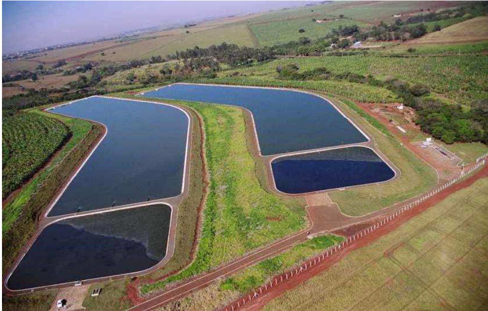
Foto 16 – Estação Tratamento de Esgoto. ETE Jacu.
