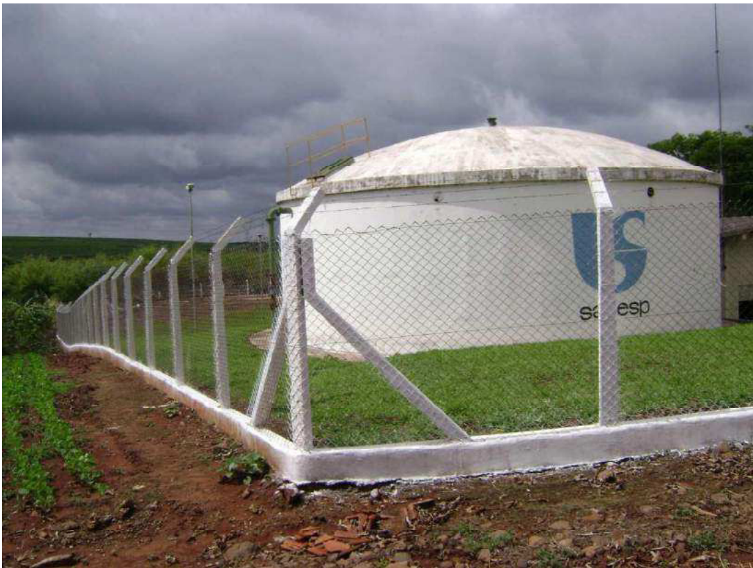
Foto 15 – Reservatório 500m3 Matão
