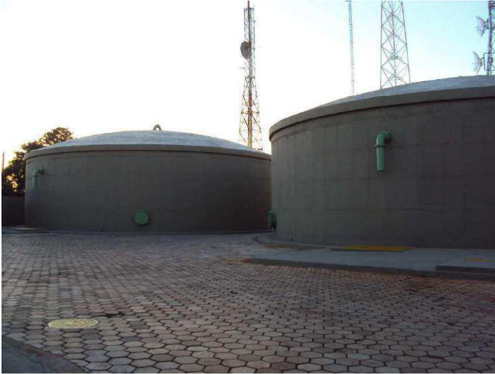
Foto 13 – Reservatório 2000m3 Vila Fiuza
