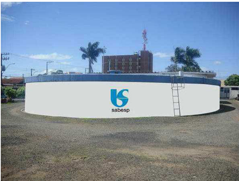
Foto 12 - Reservatório 2000m3 Estação de Tratamento de Água – ETA Boa Vista
