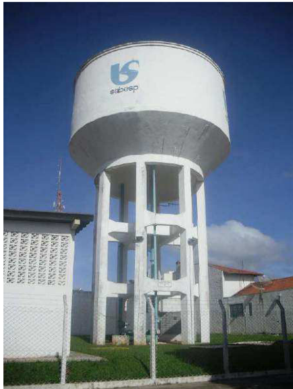
Foto 14 – Reservatório 450m3 Vila Xavier
