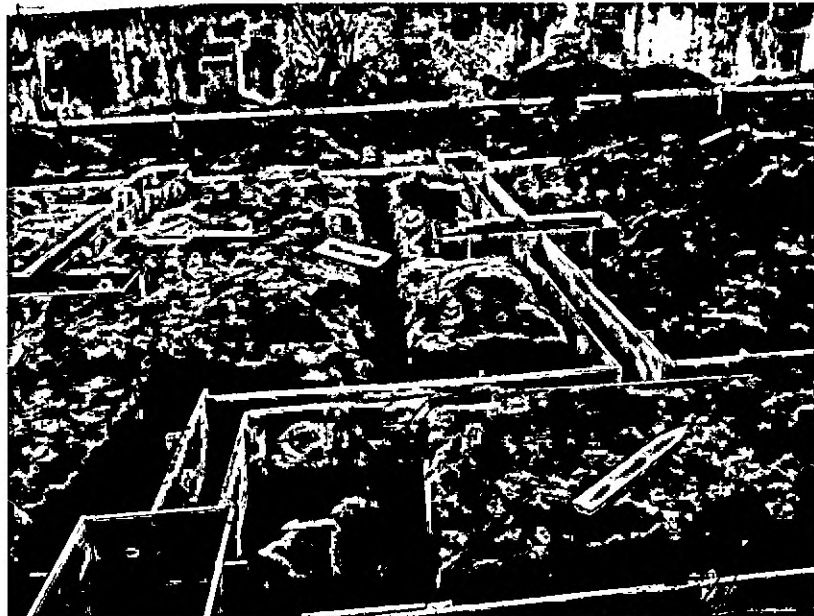
Foto 07: Formas da fundação
