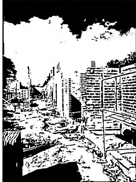
Foto 08: Blocos de salas de aula
