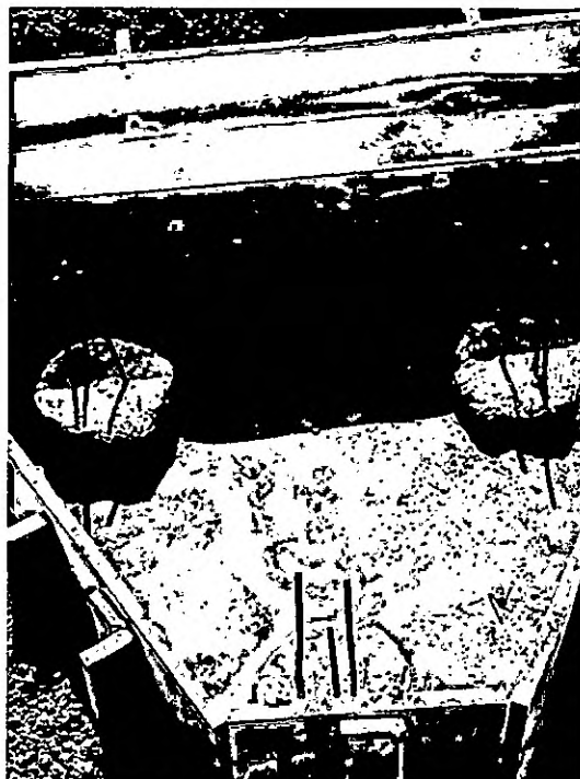
Foto 09: Bloco com três estacas
