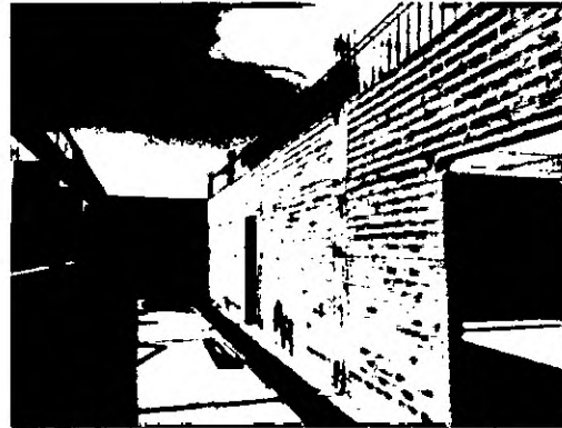
Foto 08 Alvenaria e estrutura 2º pavimento
