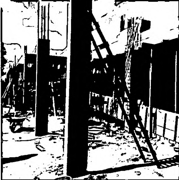
Foto 07: Pilares do pátio
