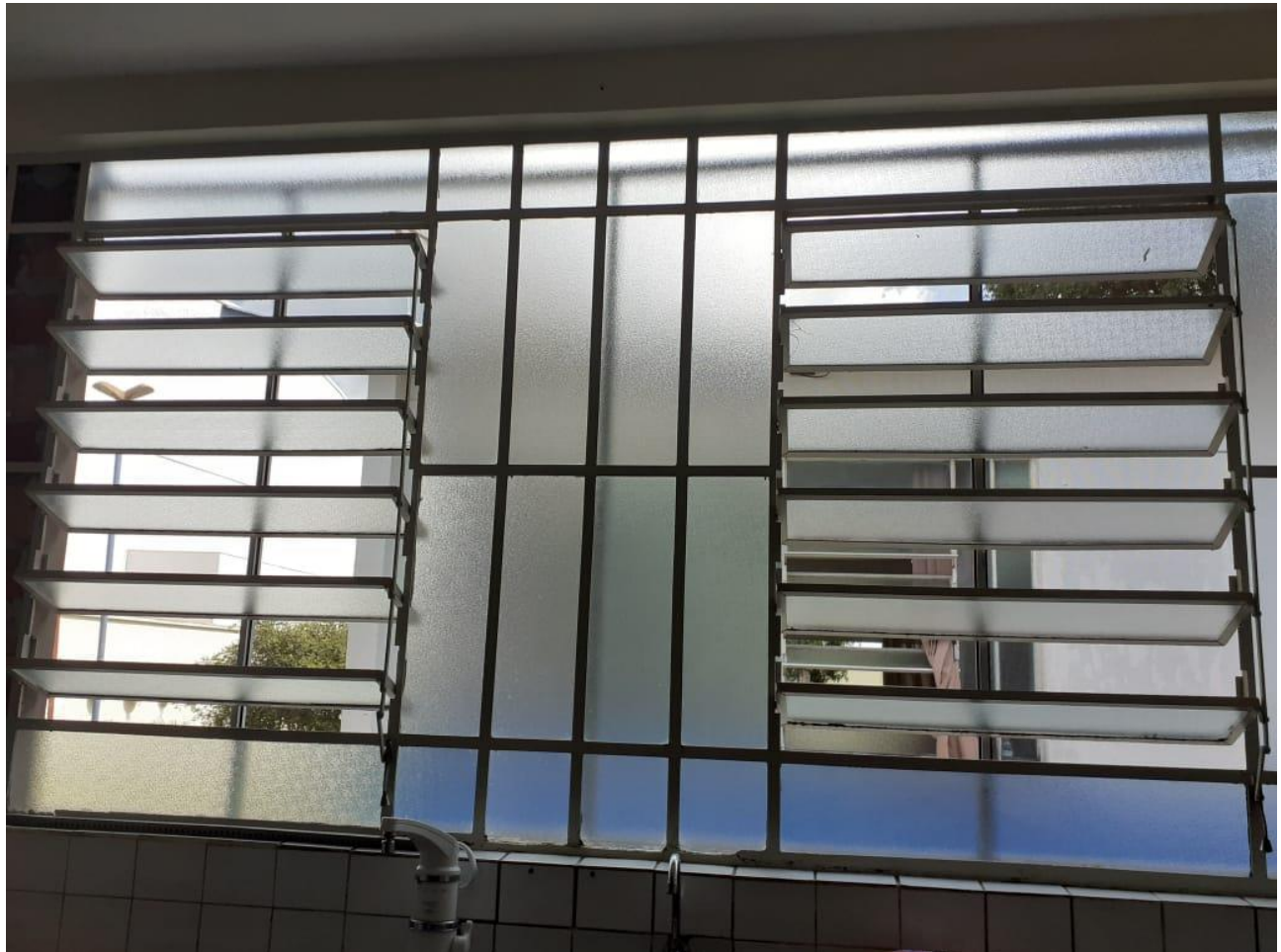
Figura 1- FOTO DA SALA INTERNA
