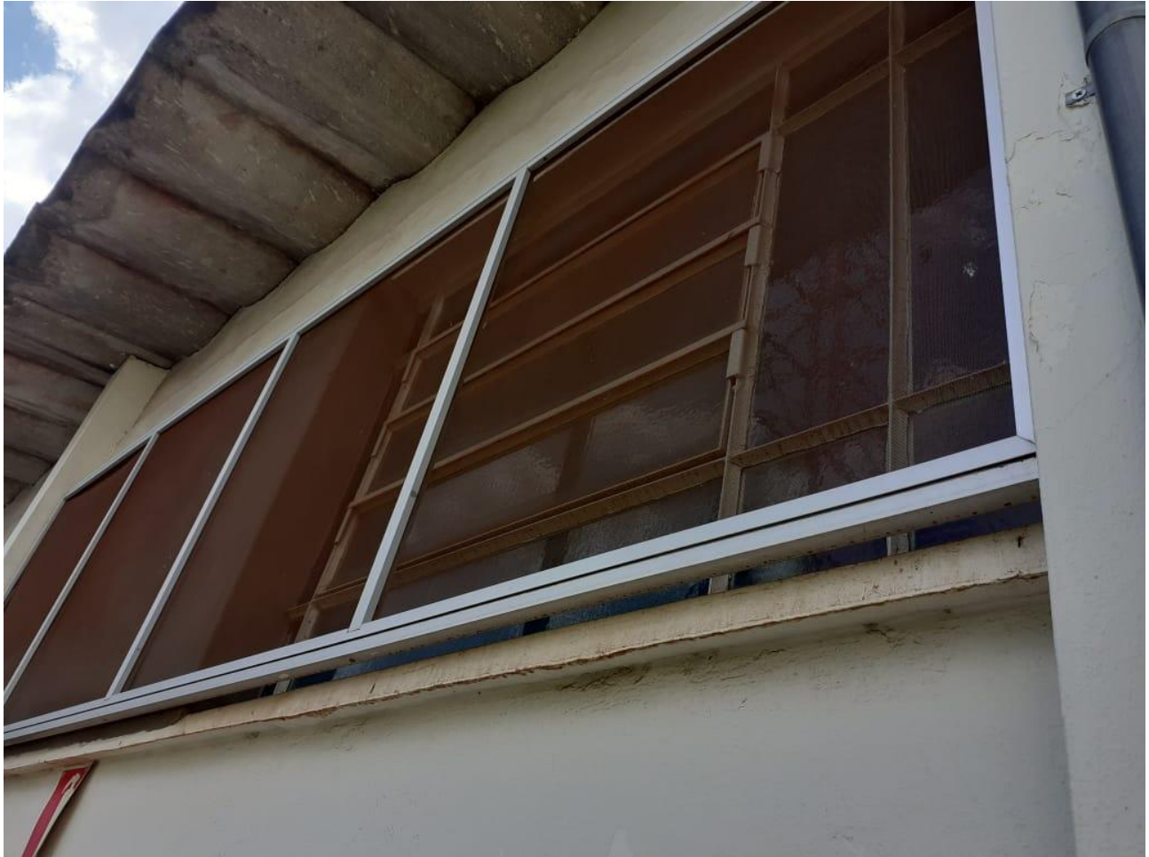
Figura 2- FOTO DA SALA PARTE EXTERNA
