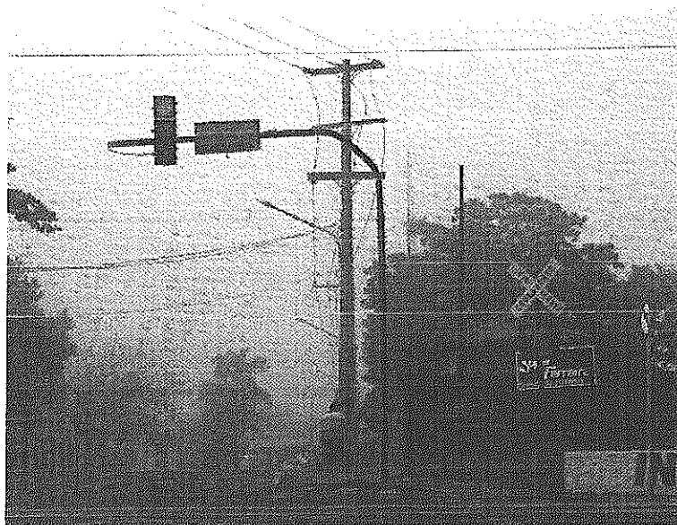
Figura 10 - Passagem em nível sem cancela
