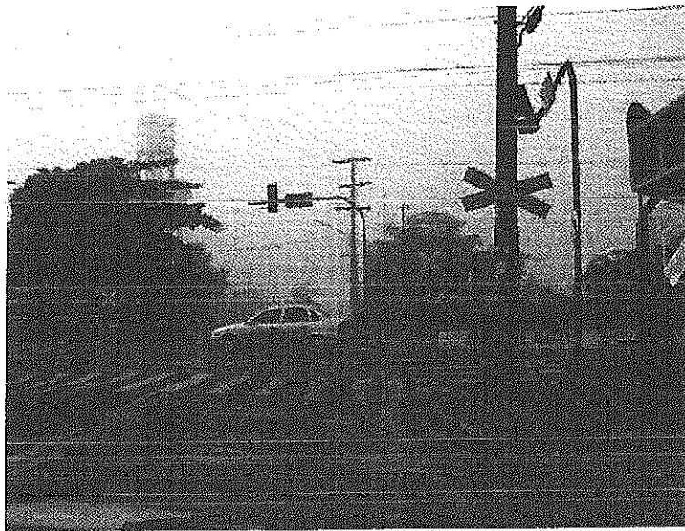
Figura 11- Passagem em nível com sinalização de advertência precária
