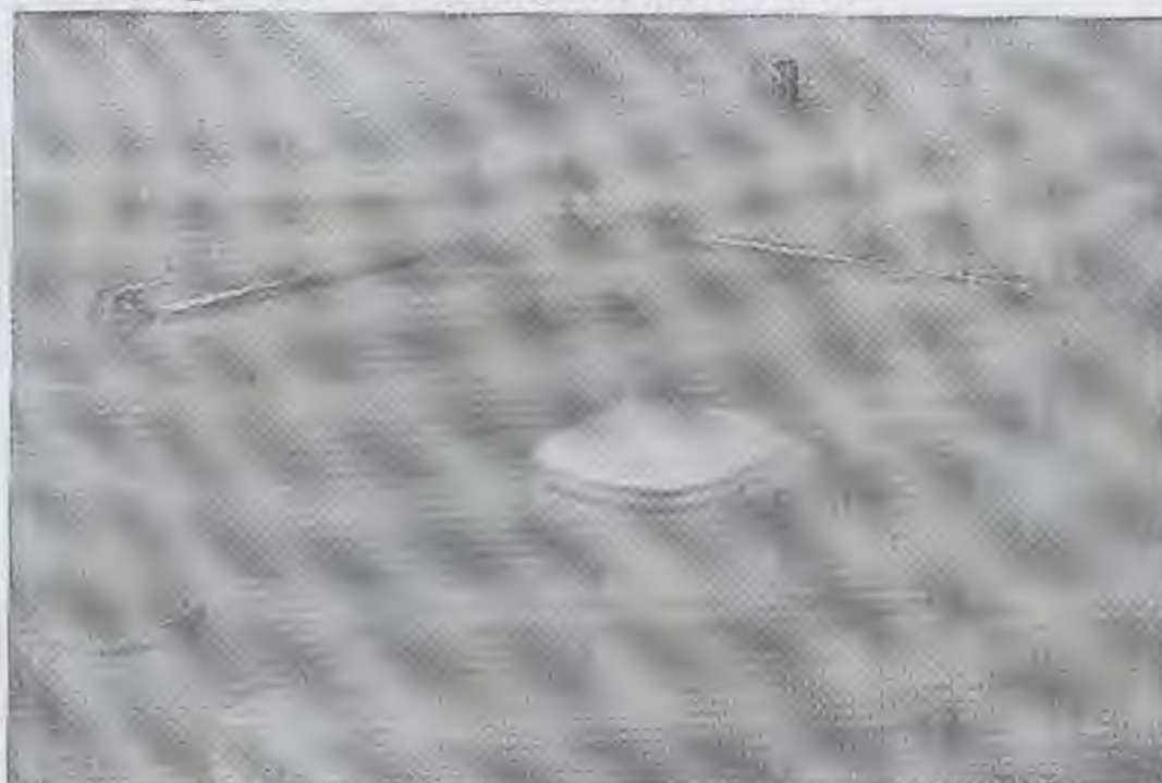
Figura 06: Aspecto das barras de apoio a fim de garantir a transferência aos P.M.R.
