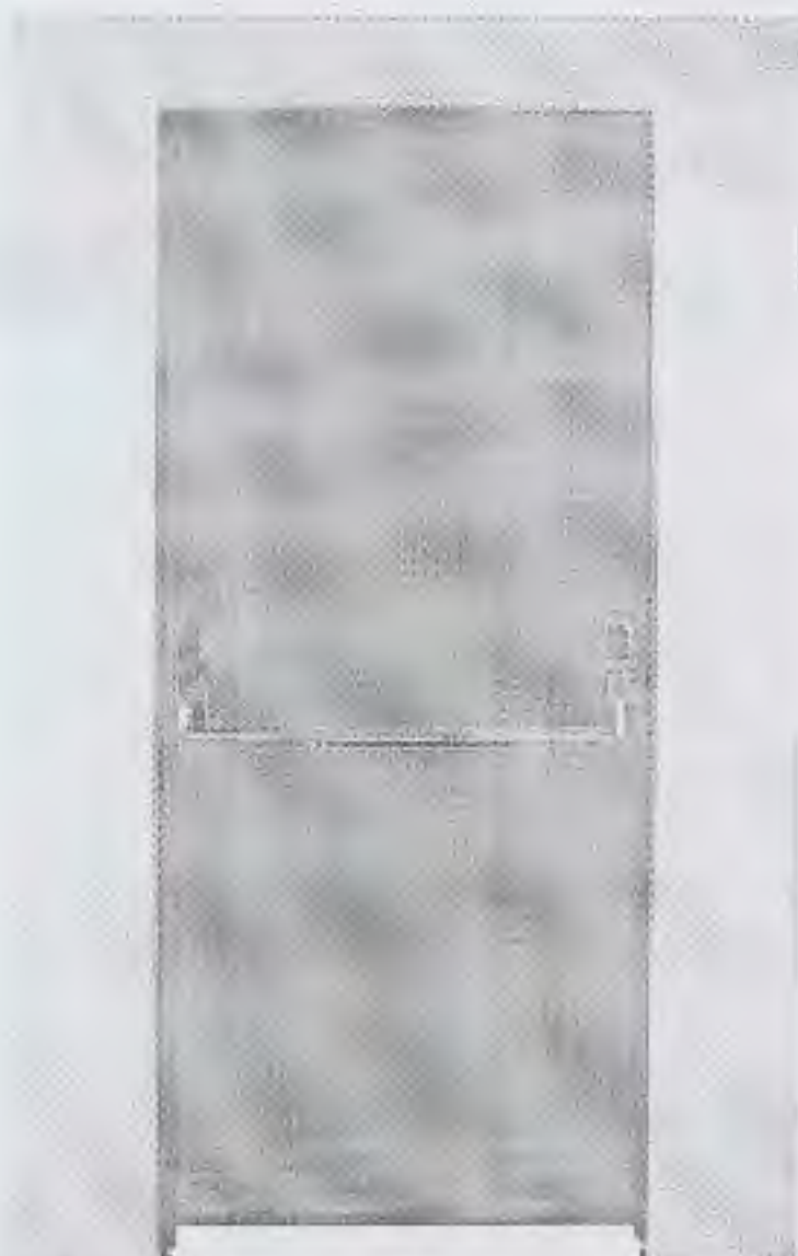
Figura 03: Aspecto da parte interna da porta de saída de emergência, inclusive barra antipânico.
