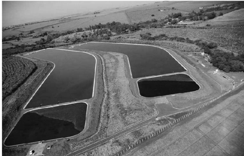
Foto 16 - Estação Tratamento de Esgoto. ETE Jacu.
