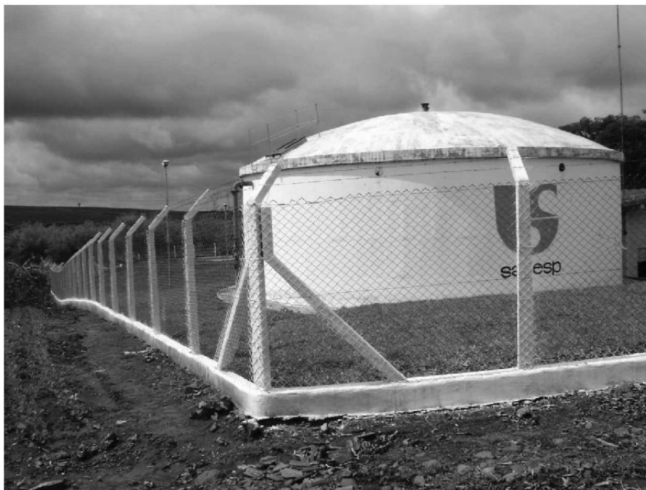
Foto 15 - Reservatório 500m 3 Matão
