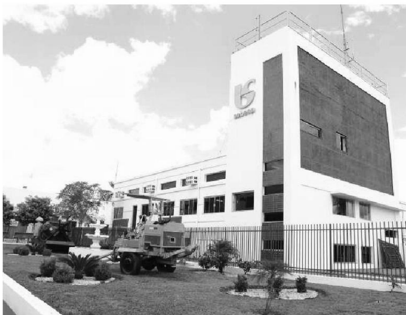
Foto 08 - Estação de Tratamento de Água - ETA Boa Vista. Vista externa
