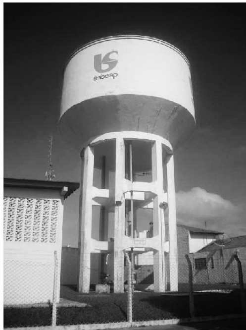
Foto 14 - Reservatório 450m3 Vila Xavier
