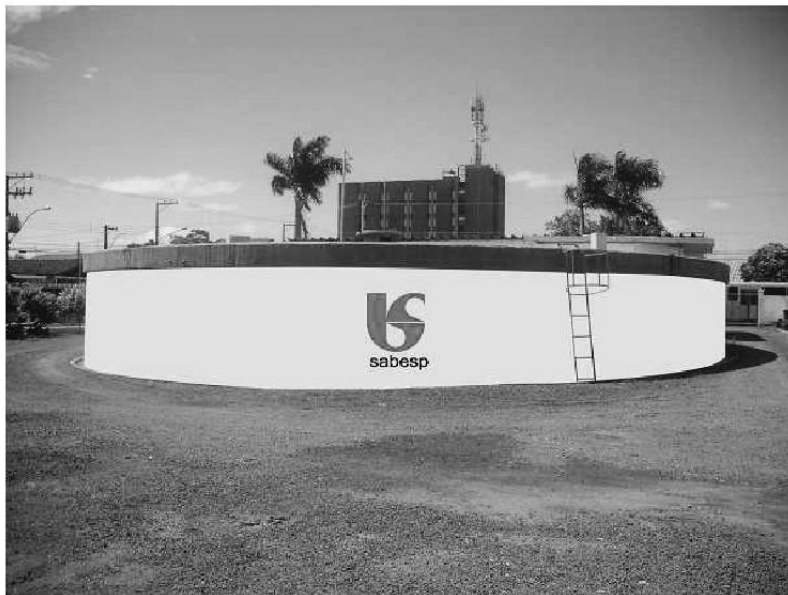
Foto 12 - Reservatório 2000m3 Estação de Tratamento de Água - ETA Boa Vista
