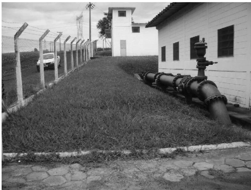
Foto 6 – Casa e Bombas do Matão
