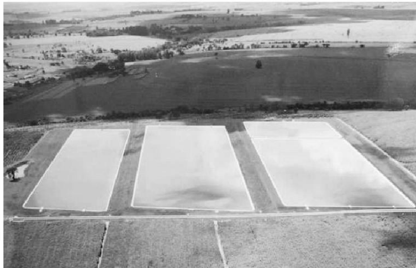
Foto17 - Estação de Tratamento de Esgoto - ETE Fortuninha.
