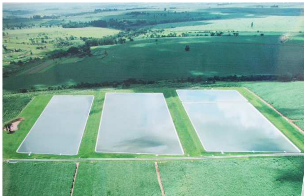
Foto17 – Estação de Tratamento de Esgoto – ETE Fortuninha.
