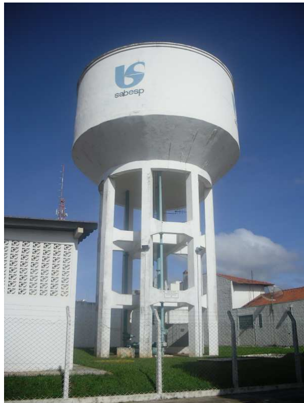
Foto 14 – Reservatório 450m3 Vila Xavier
