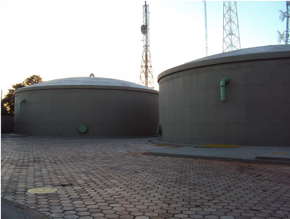
Foto 13 – Reservatório 2000m3 Vila Fiuza
