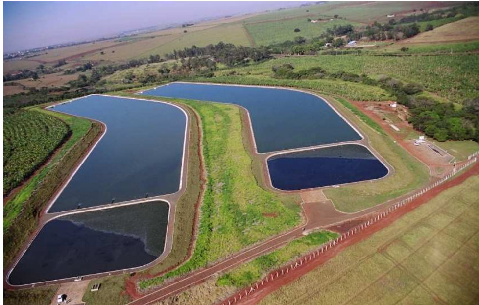
Foto 16 – Estação Tratamento de Esgoto. ETE Jacu.
