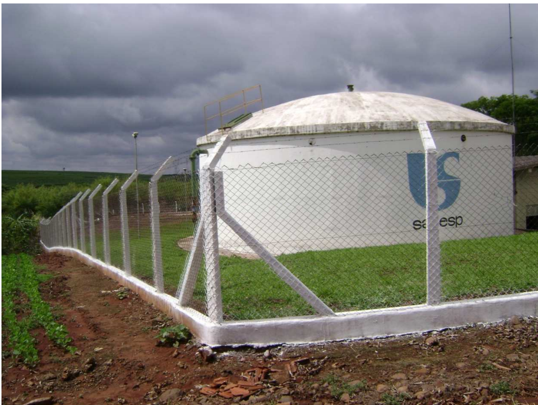
Foto 15 – Reservatório 500m3 Matão
