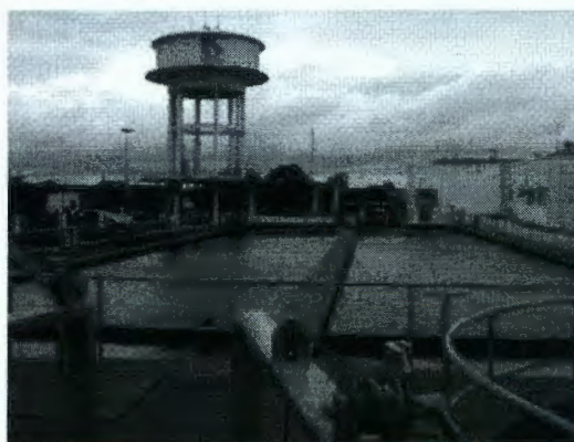
Figura 04 - Estação de Tratamento de Água (ETA).
